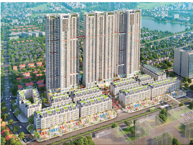
XÂY DỰNG CHUNG CƯ 公寓建设
